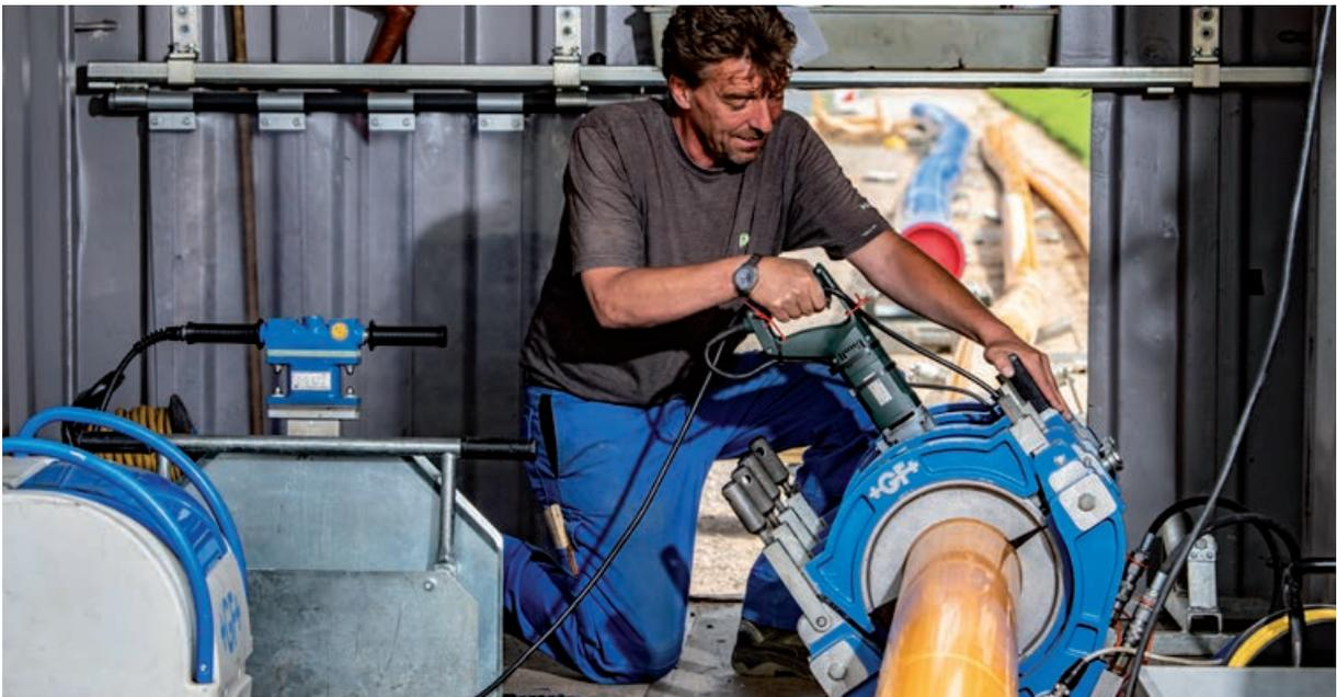
Schweißarbeiten am Gasnetz in einem mobilen Baucontainer. Über 210 Kilometer lange Leitungen werden gut 7.500 Gaskunden versorgt.
